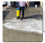
Bringen Sie den Reiniger gleichmäßig auf dem Pflasterbelag z.B. durch Verwendung eines Drucksprühers auf (ca. 0,1 bis 0,3 Liter/m²) und reinigen Sie die Fläche mithilfe von Bürste/Schrubber.
