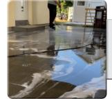
Lassen Sie TOBOLIN Intensivreiniger 5 bis 10 Minuten einwirken und spülen Sie die Fläche dann gründlich mit Wasser ab, bis keine Rückstände mehr vorhanden sind (keine Schaumbildung mehr sichtbar). Wiederholen Sie die Anwendung falls nötig.
