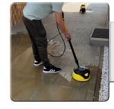
Befreien Sie die zu bearbeitende Oberfläche vor der Anwendung von groben Verschmutzungen wie Moos, Erde, Laub, etc. und nässen Sie die zu reinigende Fläche ausreichend vor. Metallelemente im Anwendungsbereich vor Kontakt mit TOBOLIN Intensivreiniger schützen.
